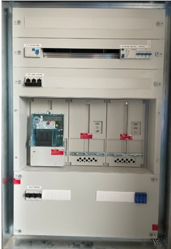
Abb.Beispiel Versiegelung Vorzählerbereich
