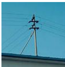
Freileitungsanschluss
