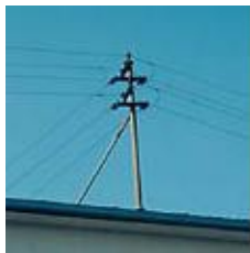
Freileitungsanschluss
