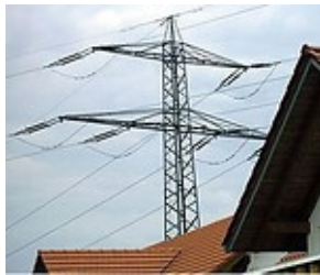
Kundenanlagen im Einflussbereich von Hochspannungsleitungen
